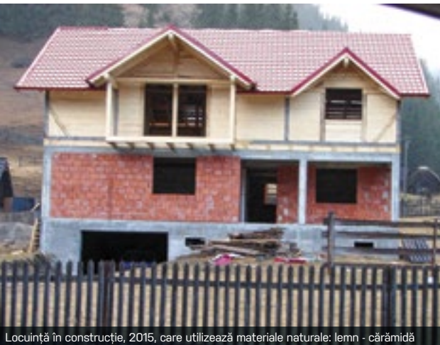
Locuință în construcție, 2015, care utilizează materiale naturale: lemn - cărămidă
