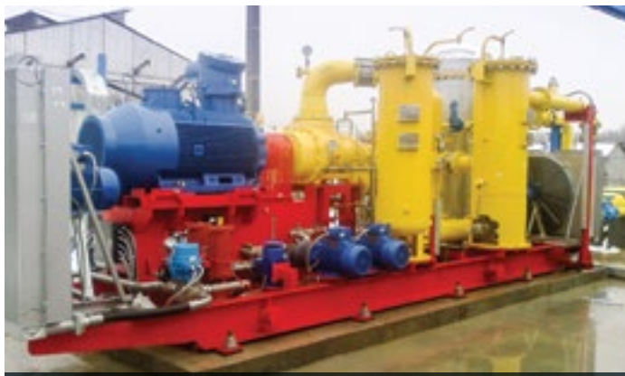
Ansamblu de comprimare ECS 75/10 în Stația Țicleni
