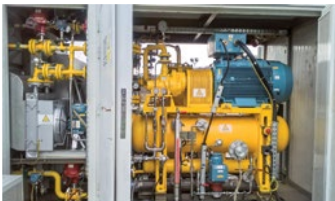
Ansamblul de comprimare ECS 5/40-B, instalat în Republica Cehă
