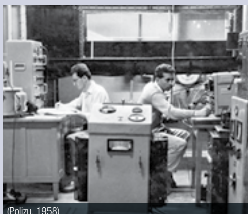
(Polizu, 1958) Instalație experimentală pentru scurgerea fluidelor vâscoase
