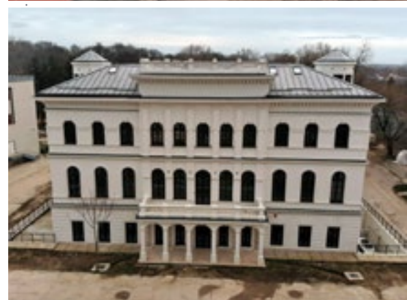
Imagini ale conacului Oteteleşanu după restaurare: stânga sus-intrarea principală; dreapta sus-turnul prăbușit, după restaurare; stânga jos-esplanada din spate, spre parc; dreapta jos-vedere aeriană a conacului.
