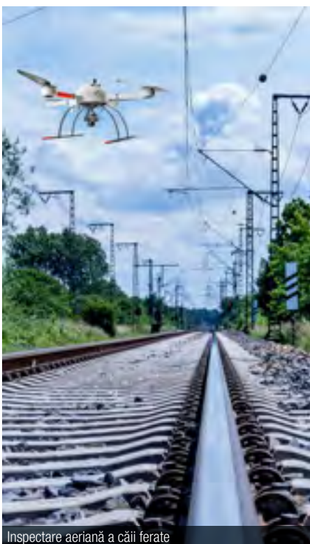
Inspectare aeriană a căii ferate
