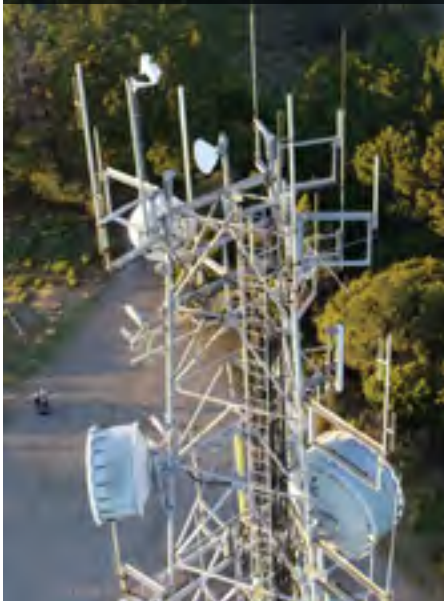
Inspectare antenă GSM cu drona
