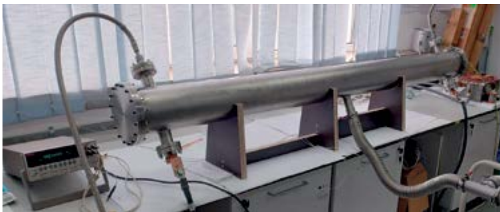
Fig. 1. Cablu electric supraconductor HTS realizat în ICPE-CA
