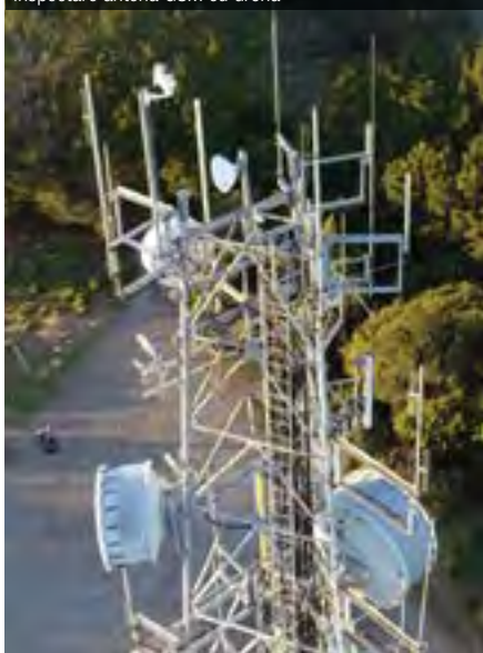
Inspectare antenă GSM cu drona
